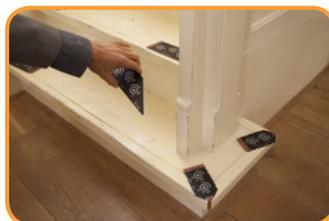
Tutti i montascale di Handicare vengono progettati in maniera tale da adattarsi alla conformazione specifica della propria scala. Ci serviamo dell'avanzata tecnologia di PhotoSurvey per effettuare misurazioni accurate e disponiamo di tutti gli strumenti necessari per realizzare la soluzione migliore per ogni scala.
